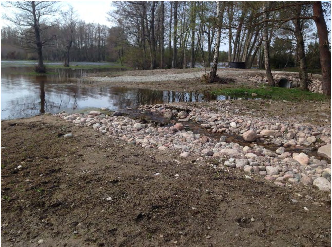
Utloppsfåra samt vägbro över kulvert från munk. Foto: 2019-04-28 Börje Ekstam.
