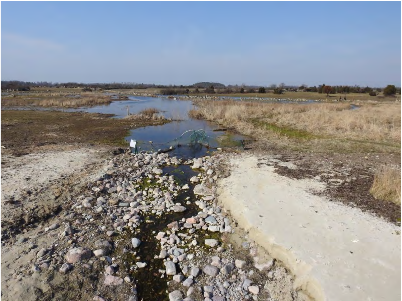
Utloppströskeln nedströms den krävda kanalfåran. Foto: 2019-04-06 Börje Ekstam
