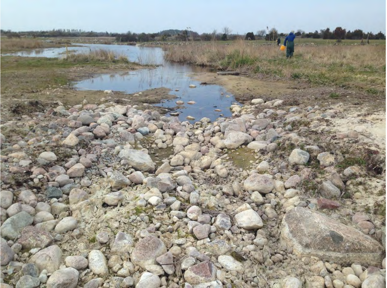
Utloppsfåran torrlagd nedströms tröskeln. Foto: 2019-04-28 Börje Ekstam
