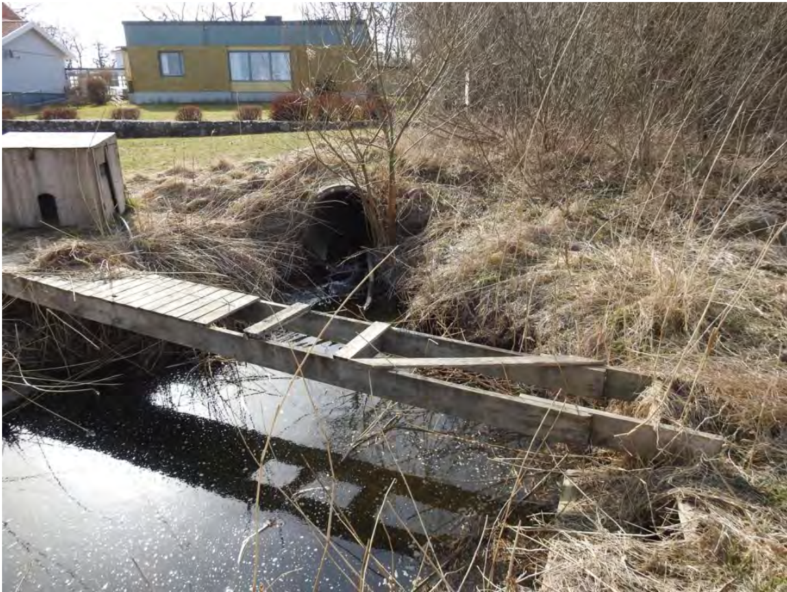
Figur 11: Utloppet för den kulverterade Rosenforskanalen. 2018-04-13.
